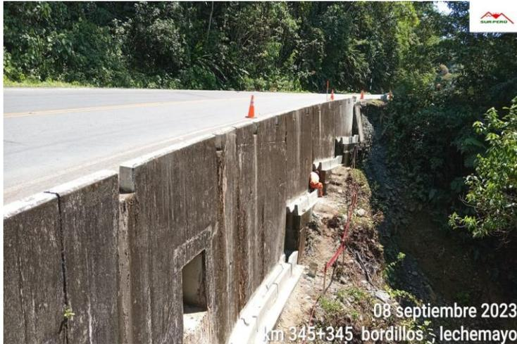
Sistema de drenaje –recuperación y construcción de bordillo km 345+300
