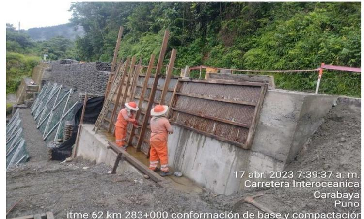
Estabilización de talud inferior – Sistema erdox km 282+900 al km 283+000
