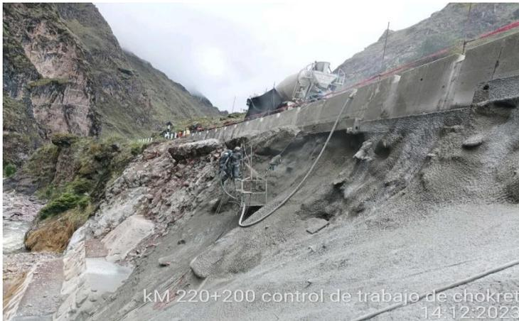
Estabilización de talud inferior - Soilnailing km 220+200
